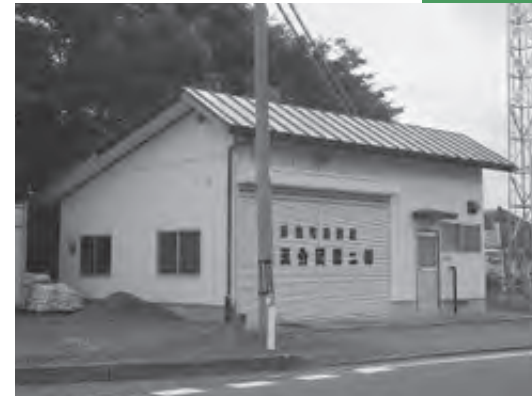
消防屯所は地域防災の要です
