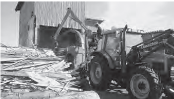
木質チップ製造作業
