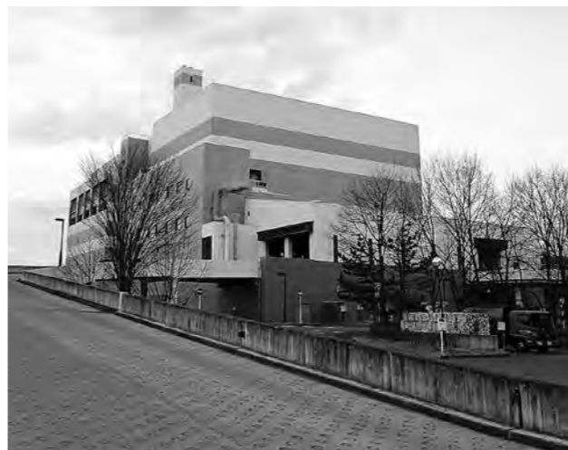
盛岡・紫波地区環境施設組合 清掃センター
