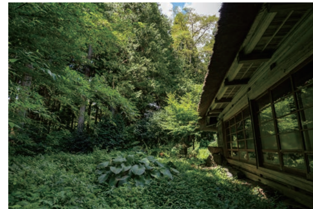
(42) 南側庭園現況
