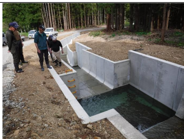
水路工事、維持管理
