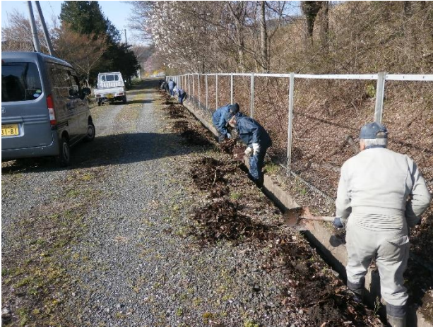
春先には、排水溝の泥上げを実施しました。
