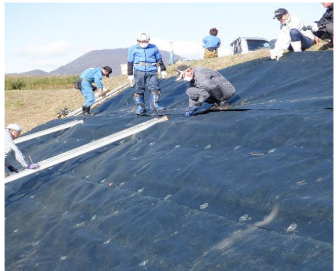
水田法面等の高傾斜面の防草シート敷設
