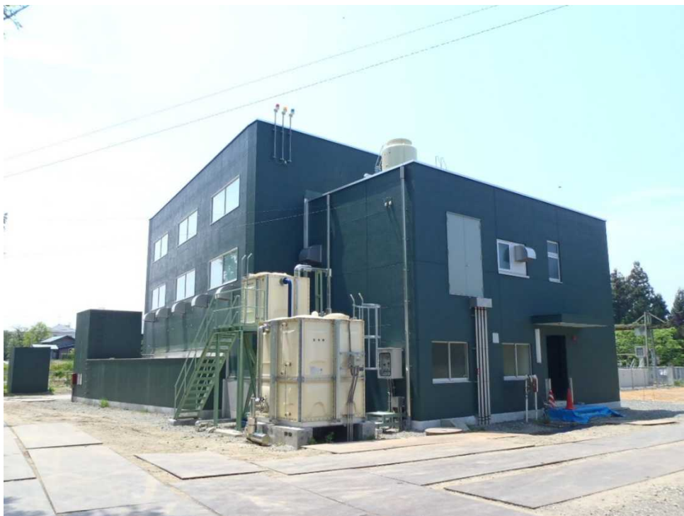
(下川原ポンプ場)
