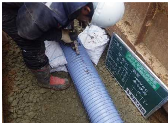
(汚水管渠敷設の様子・塩ビ管)
