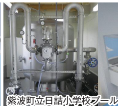
紫波町立日詰小学校プール改築(機械設備)工事
