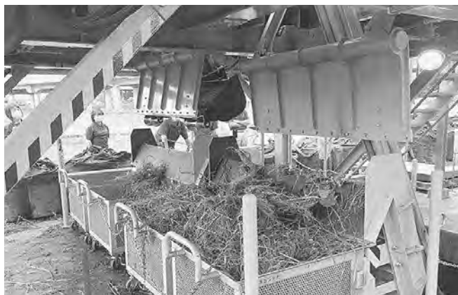
大坪川分水工の除じん機
