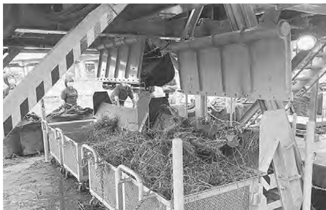
大坪川分水工の除じん機
