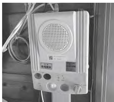
緊急通報装置（イメージ）
