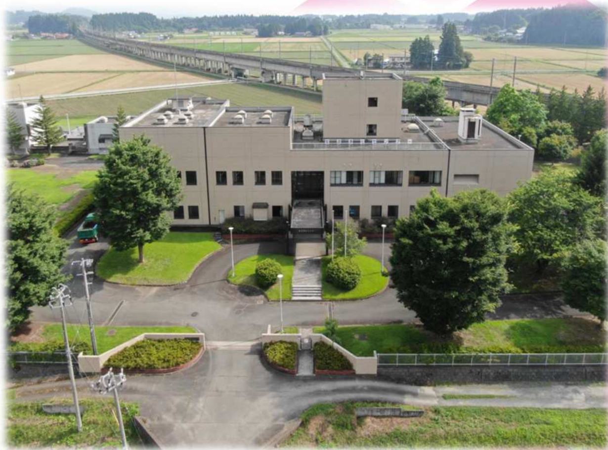
紫波浄化センター（北側より空撮）
