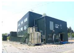
下川原ポンプ場
