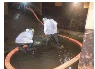
ポンプ井に堆積した土砂等の撤去・清掃
